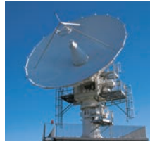
勝浦第3受信局用パラボラアンテナ
